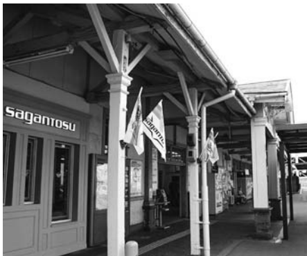
写真5 正面下屋の柱と方杖
