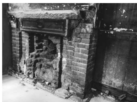
写真13 内部改修時の暖炉と豎板張りの腰壁 (5)
