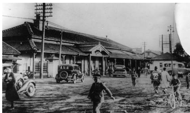
写真17 昭和10年頃 下屋の鼻隠し飾りはなくなり、南側の煙突も撤去。時計が設置されている。 (3)
