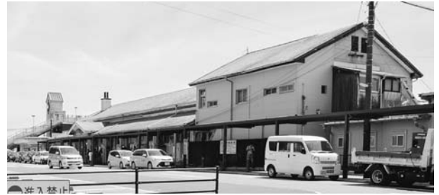
写真19 南西から見た現在の駅舎 屋根が瓦から化粧スレートへ葺き替えられている
