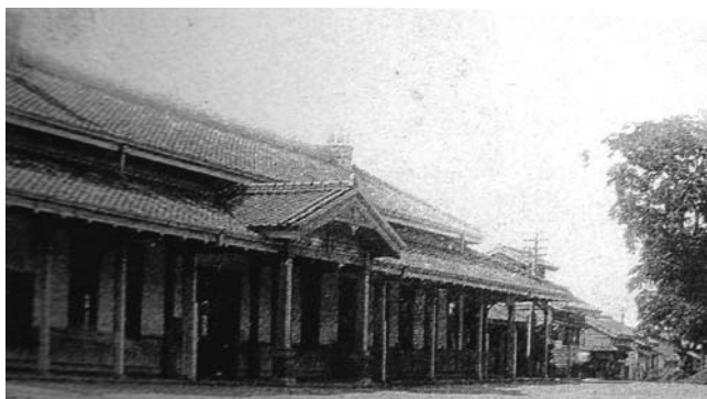
写真2 建設当初の西洋風の西側側正面 煙突が2基ある 車寄せの時計は最初は設置されていない 1)
