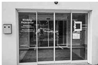
(c) 段差のない玄関
