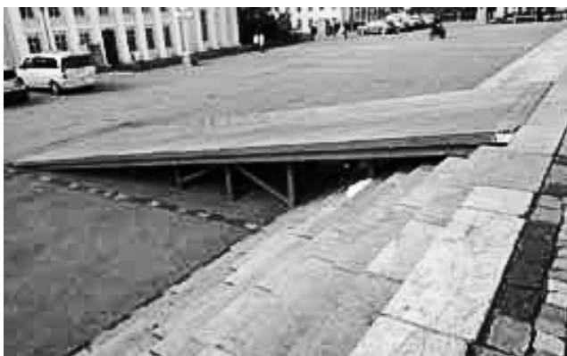
(b) 歴史的建物の階段に設置されたスロープ
