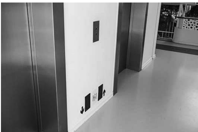
(h) 足で操作できるエレベーターボタン
