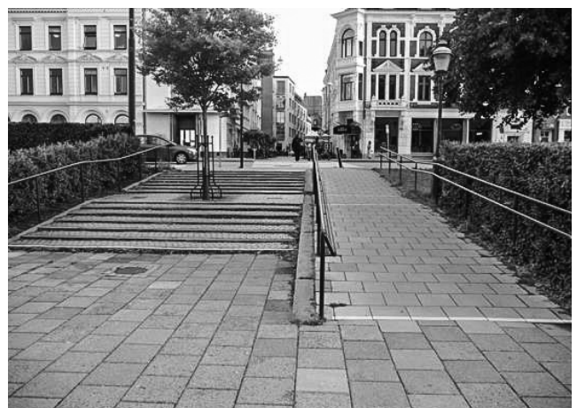
(b) 階段横に設置されたスロープ
